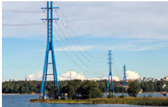
Neues Design der Hochspannungsleitungen in Helsinki
